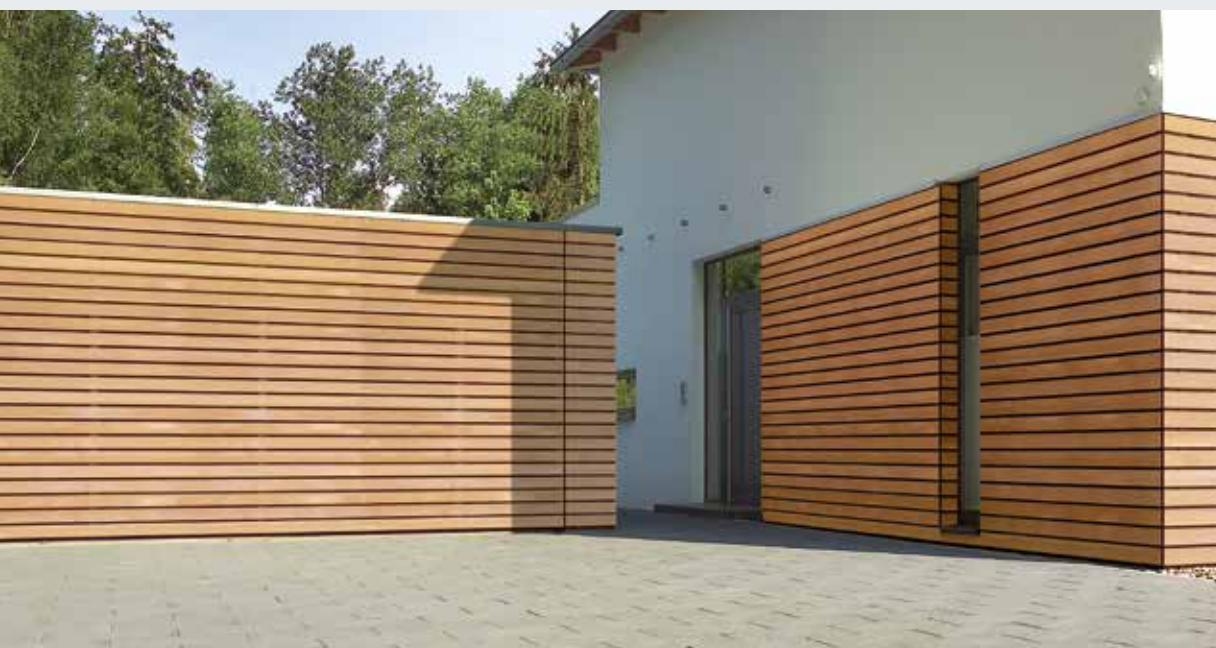
Облицовка деревянными панелями, выполняемая заказчиком
