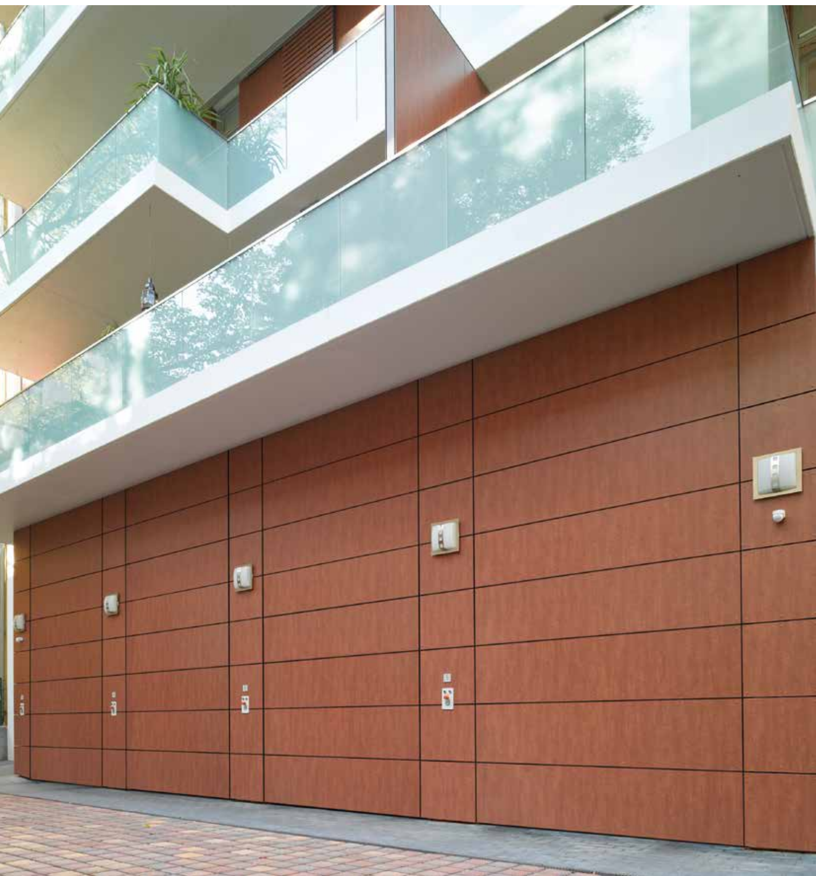
Облицовка древесно-стружечными плитами, выполняемая заказчиком
